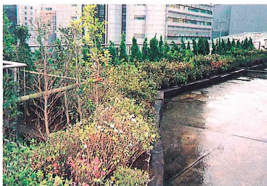
▲地下鉄駅ビル屋上
